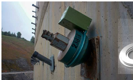
Cabeza de anclaje con barra roscada y tuerca
