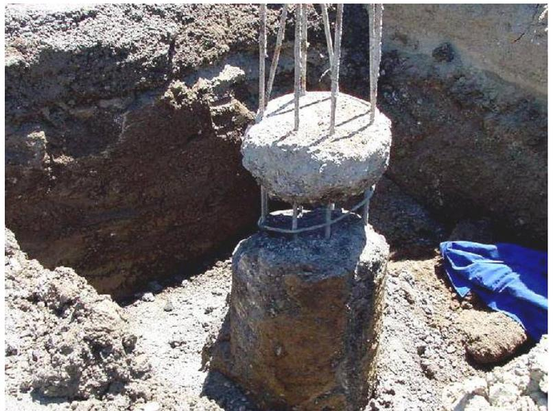
Corte en la cabeza del pilar detectado en ensayo
