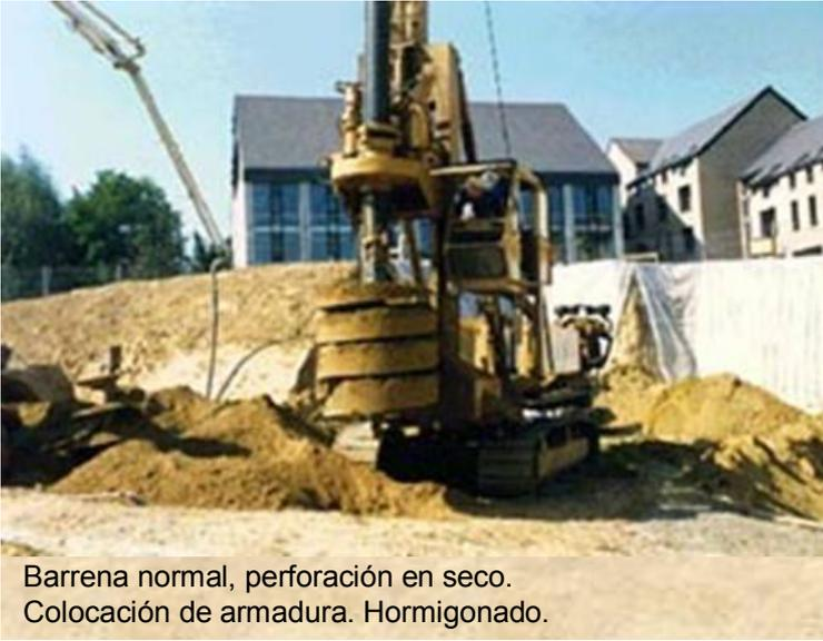
Barrena normal, perforación en seco.
