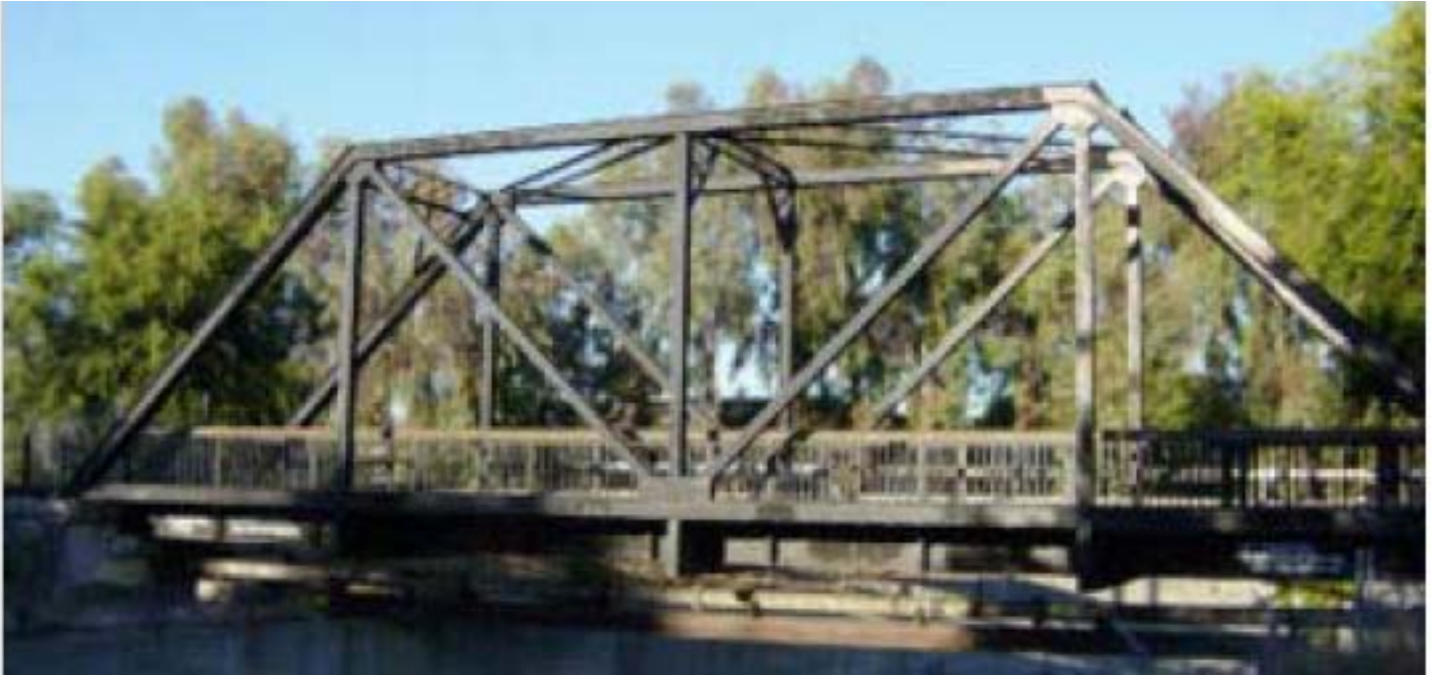
Puente con vigas Pratt
