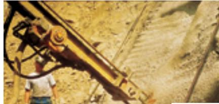
Perforación con barra de anclaje
