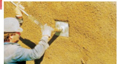
Tensado del anclaje con llave dinamométrica o gato de pistón hueco
