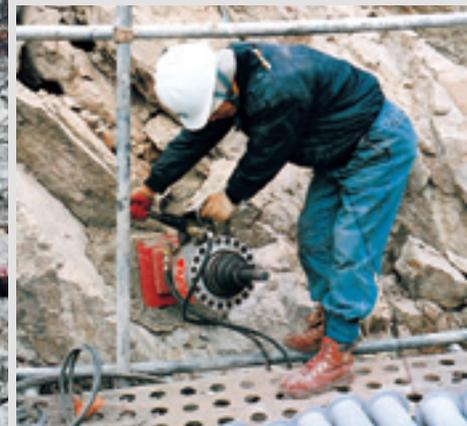
Tensado del anclaje con gato DYWIDAG
