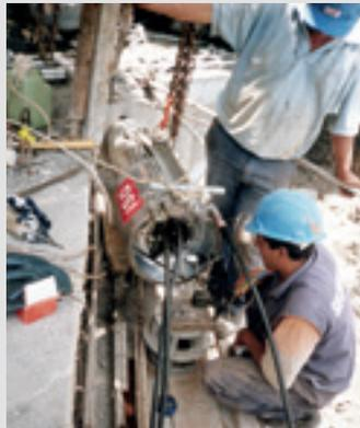
Ensayos de tesado en los anclajes
