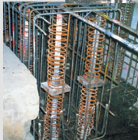
Alzado del detalle de un cabezal de pilote GEWI® (compresión/tracción)
