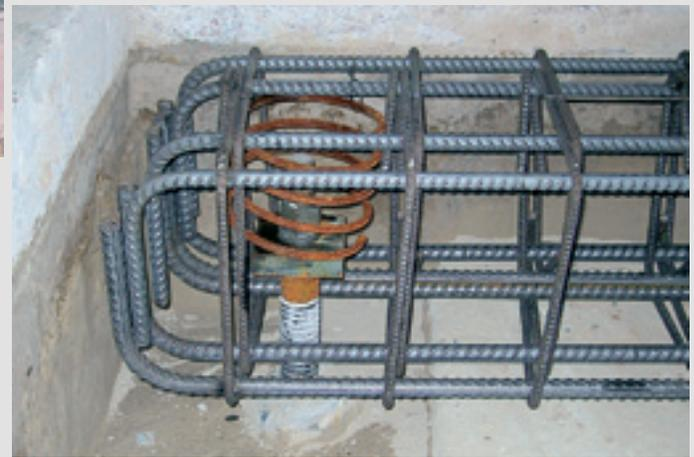
Detalle del cabezal del pilote **GEWI**<sup>®</sup> (compresión)
