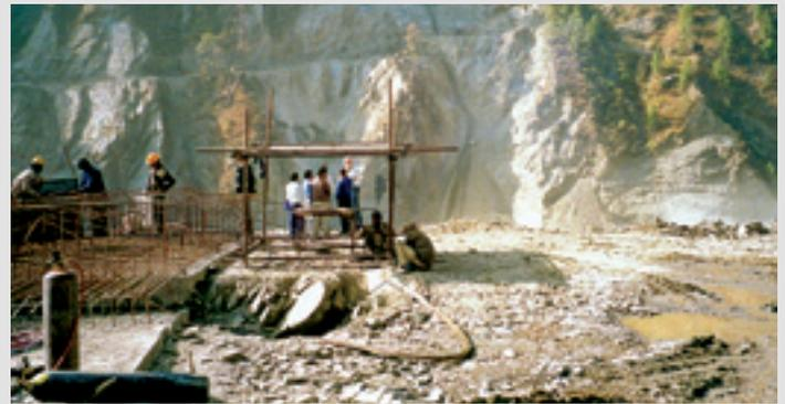
Equipo de instalación subterráneo; pequeña foto: operaciones de tesado con gatos locales utilizando una silla de tensado
