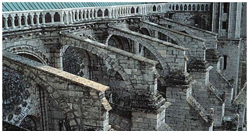
Arriostramiento con muro contrafuerte o arbotantes
